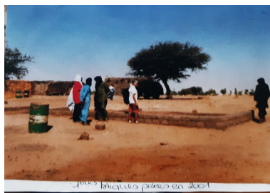
Début des travaux
