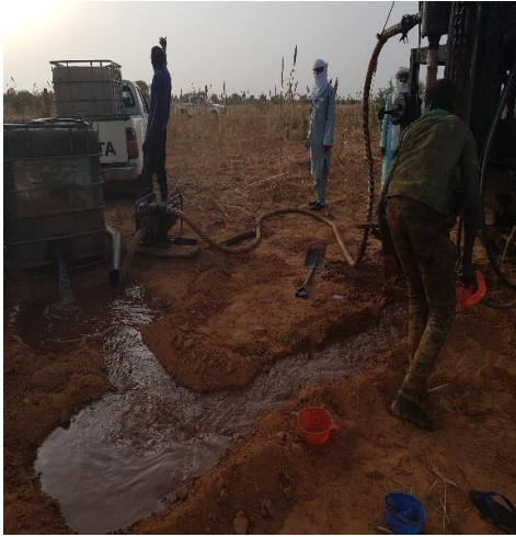
Début des travaux de forage
