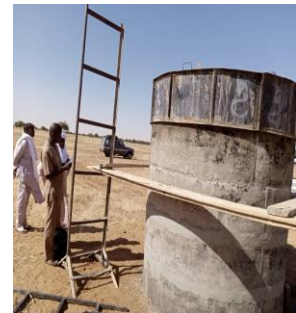
Supervision des travaux de bassins
