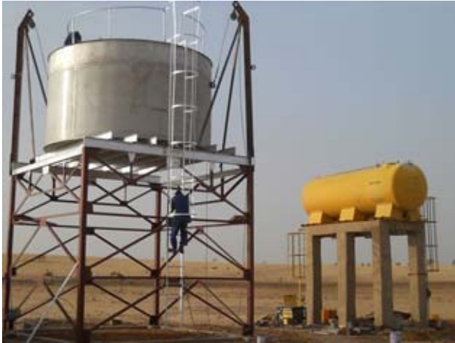
Le nouveau château d'eau à côté de l'ancien
