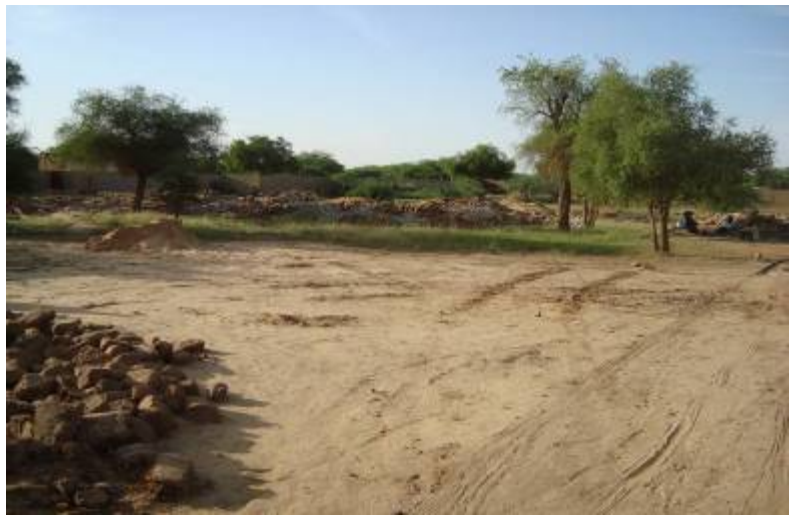
Vue d'ensemble 15 jours après : le travail de déblaiement a déjà bien commencé
