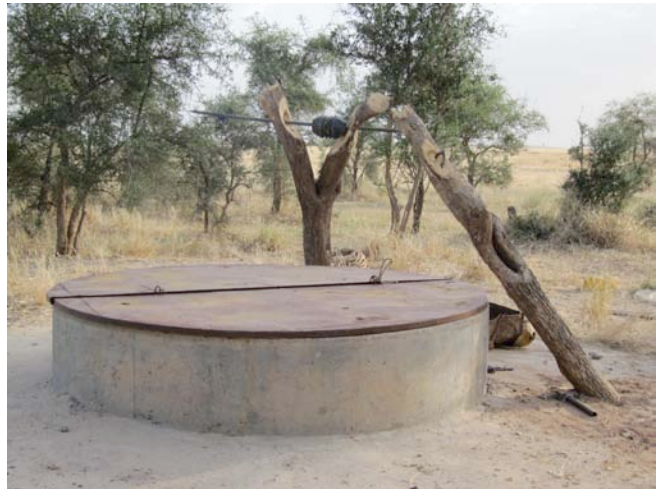
En octobre 2010 deux fourches étaient en service et un couvercle en métal mis en place pour la propreté de l'eau
