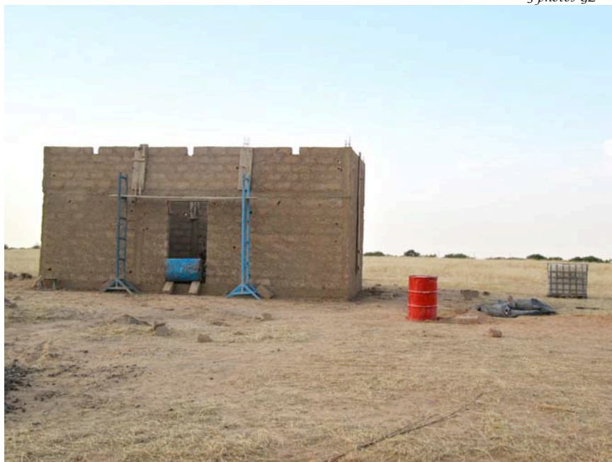
Le magasin de stockage des aliments pour bétail, en cours de finition en octobre sera approvisionné en novembre 2010
