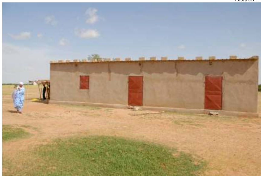
Construction comprenant de droite à gauche une Boutique Femme, une Banque Céréalière et une Banque Aliments Bétail
