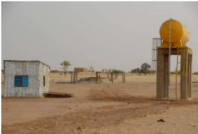
L'abri du groupe électrogène, le puits et la citerne
